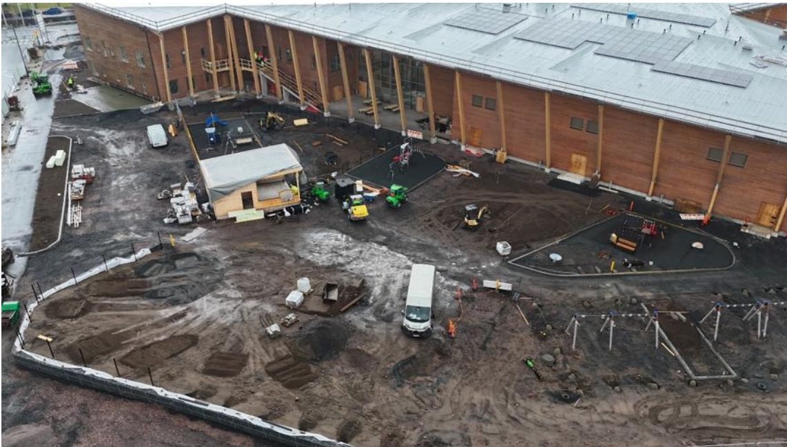
Pihatyöt käynnissä. Kuva 9.9.2026
