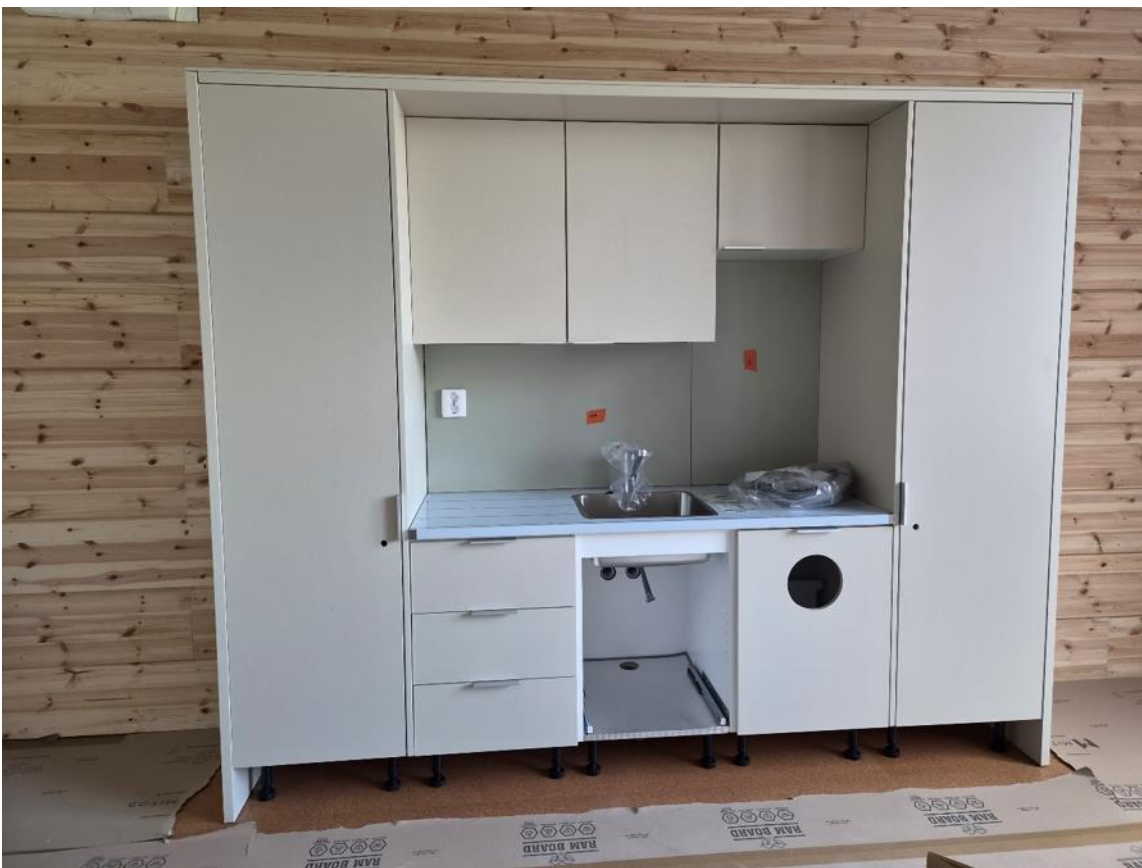
Kalusteita asennettuna A-lohkolla. Kuva 10.9.2026
