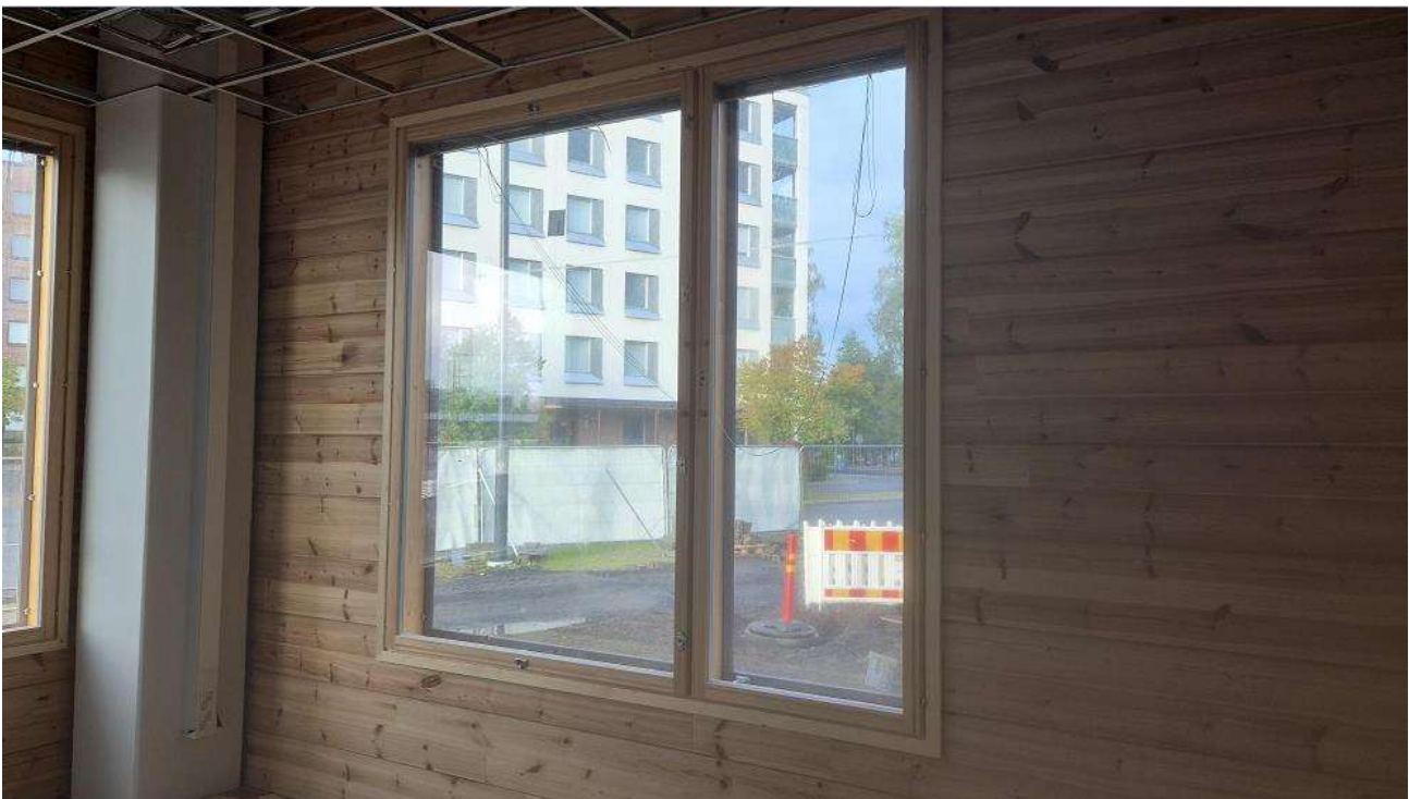
Listoitustyöt käynnissä päiväkodin alueella. Kuva 17.9.2026.
