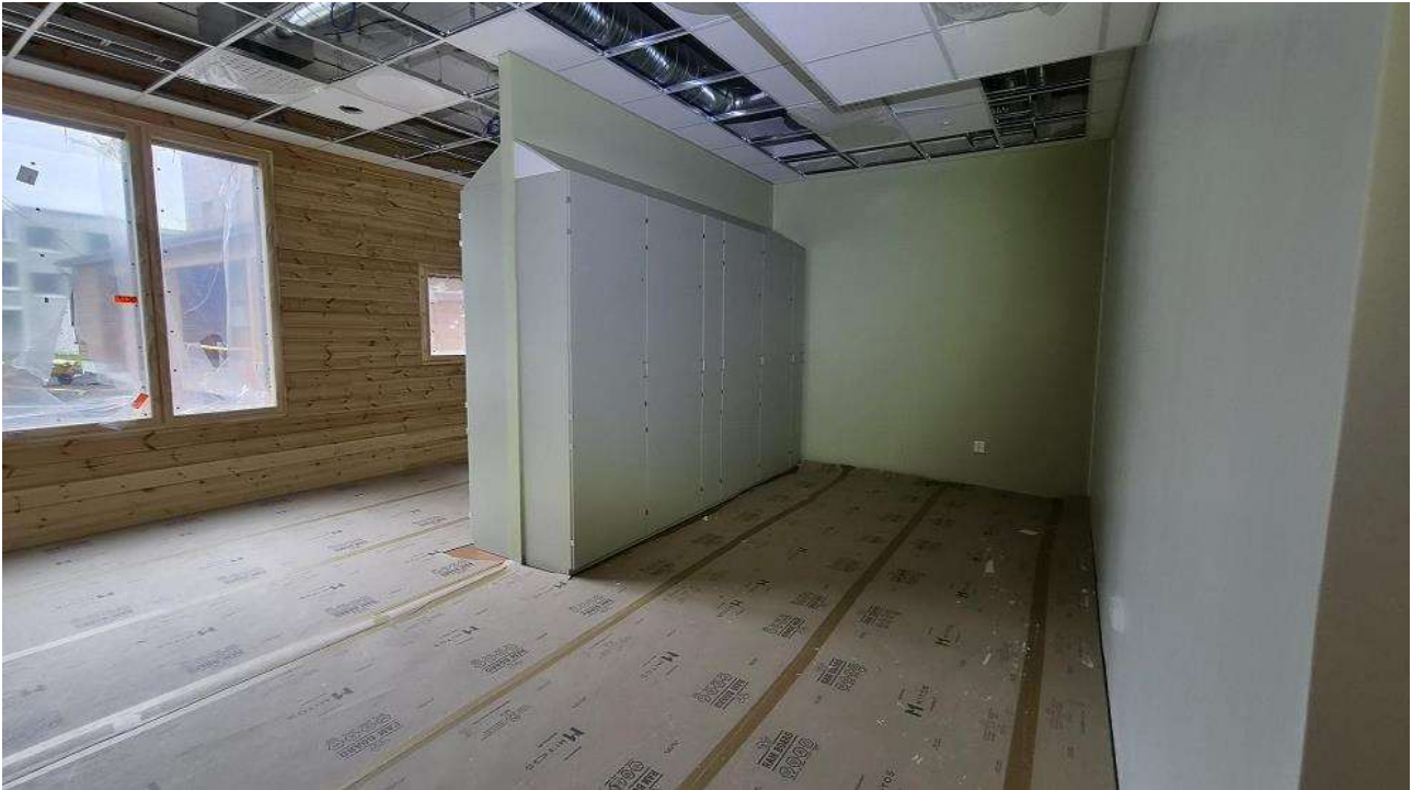
Sänkyjä asennettuna päiväkodin puolelle. Kuva 16.9.2026.
