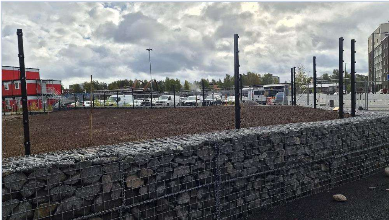
Aitatolpat asennettuna. Kuva 17.9.2026.
