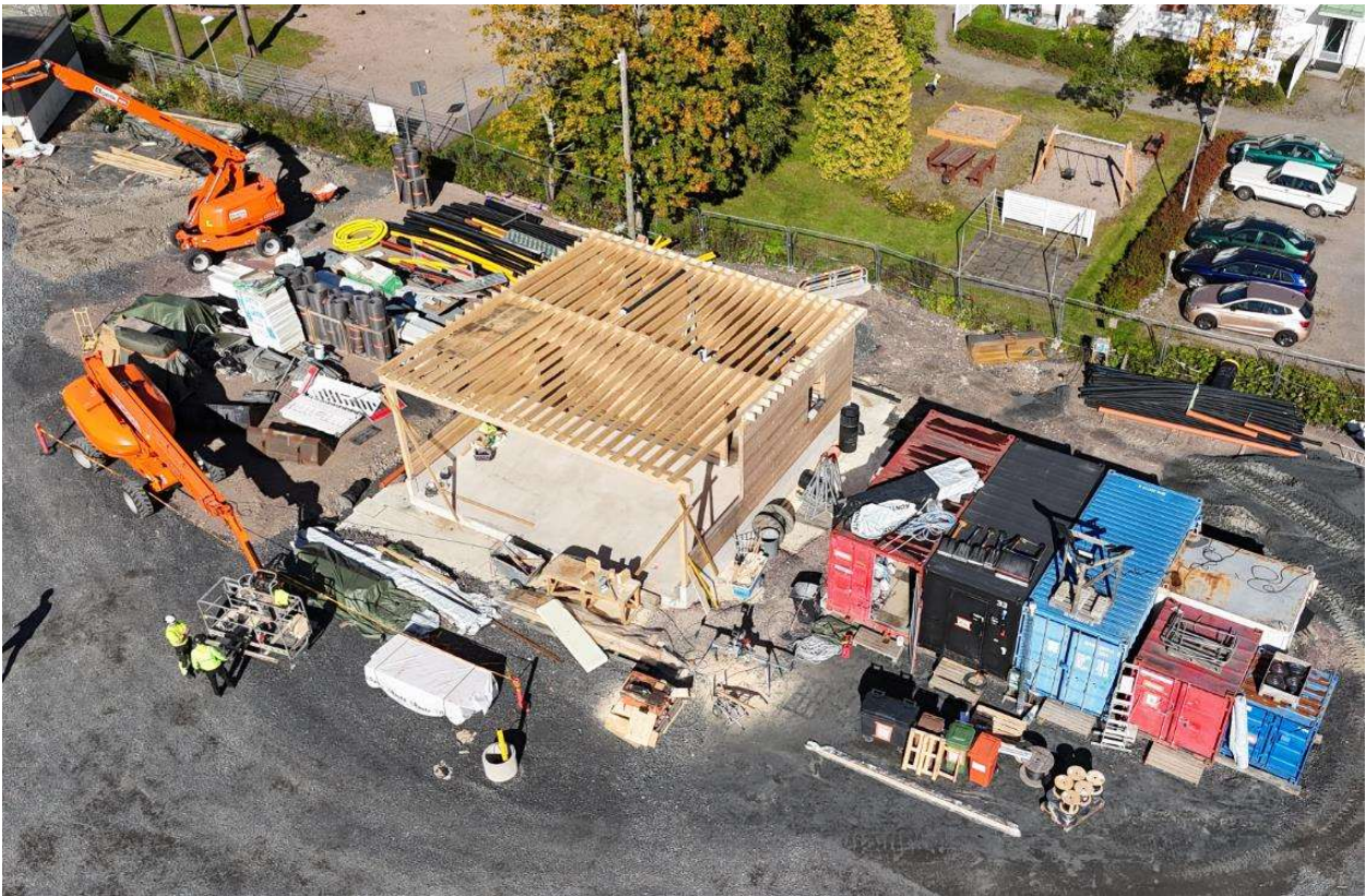
Koulun puolella ulkavälinevaraston kattotyöt käynnissä. Kuva 15.9.2026.
