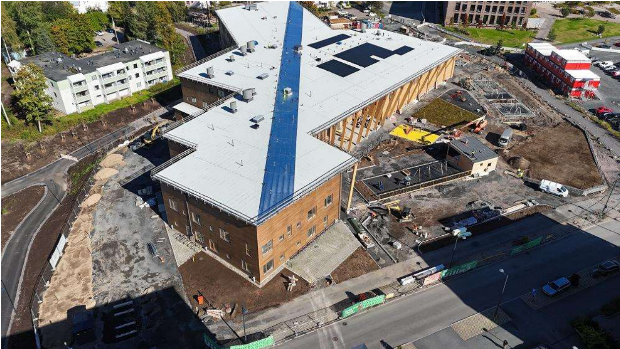
Päiväkodin pihaa tehdään kovaa tahtia valmiiksi. Kuva 15.9.2026.
