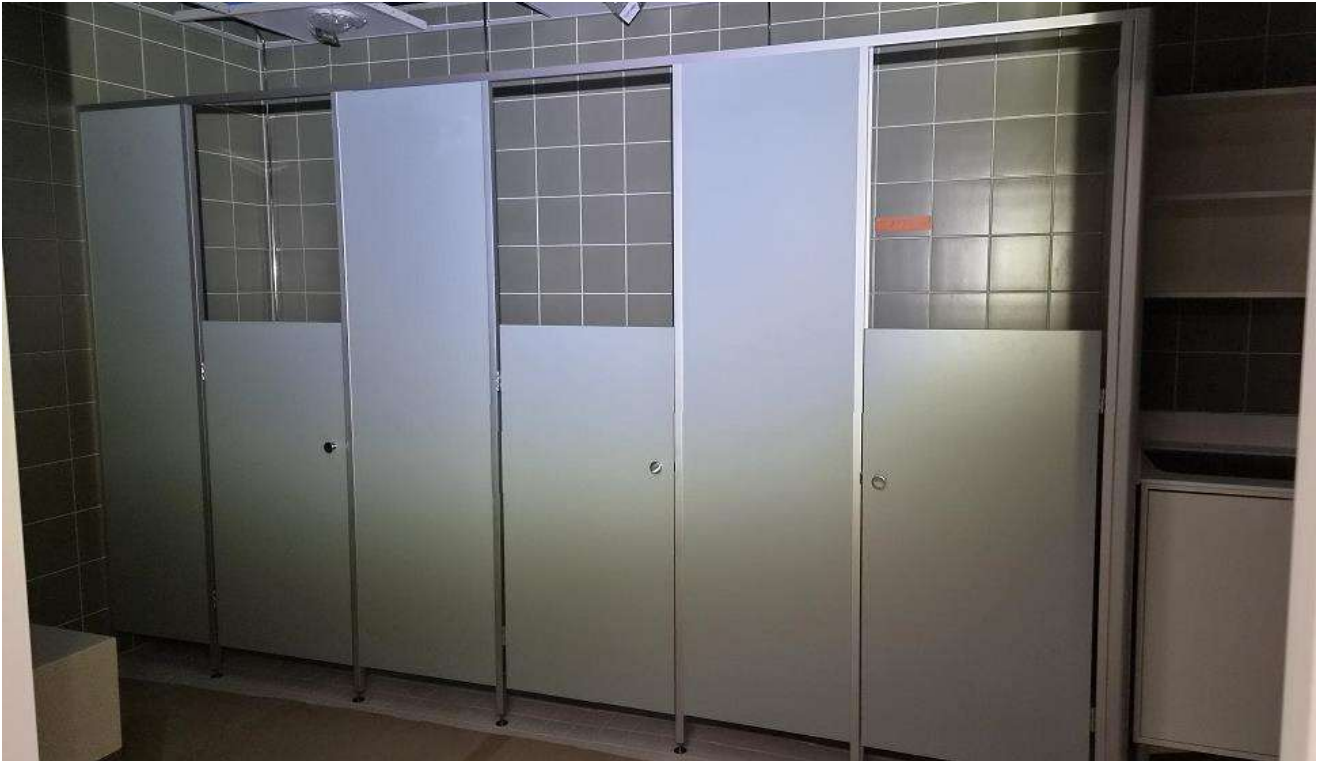
Laminaatijakoseiniä asennettuna päiväkotiin. Kuva 23.9.2026
