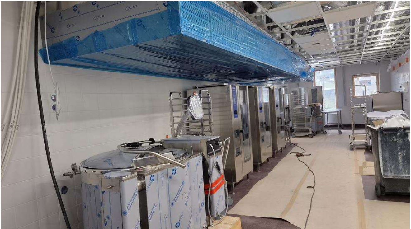
Keittiön laitteiden asennus käynnissä. Kuva 24.9.2026
