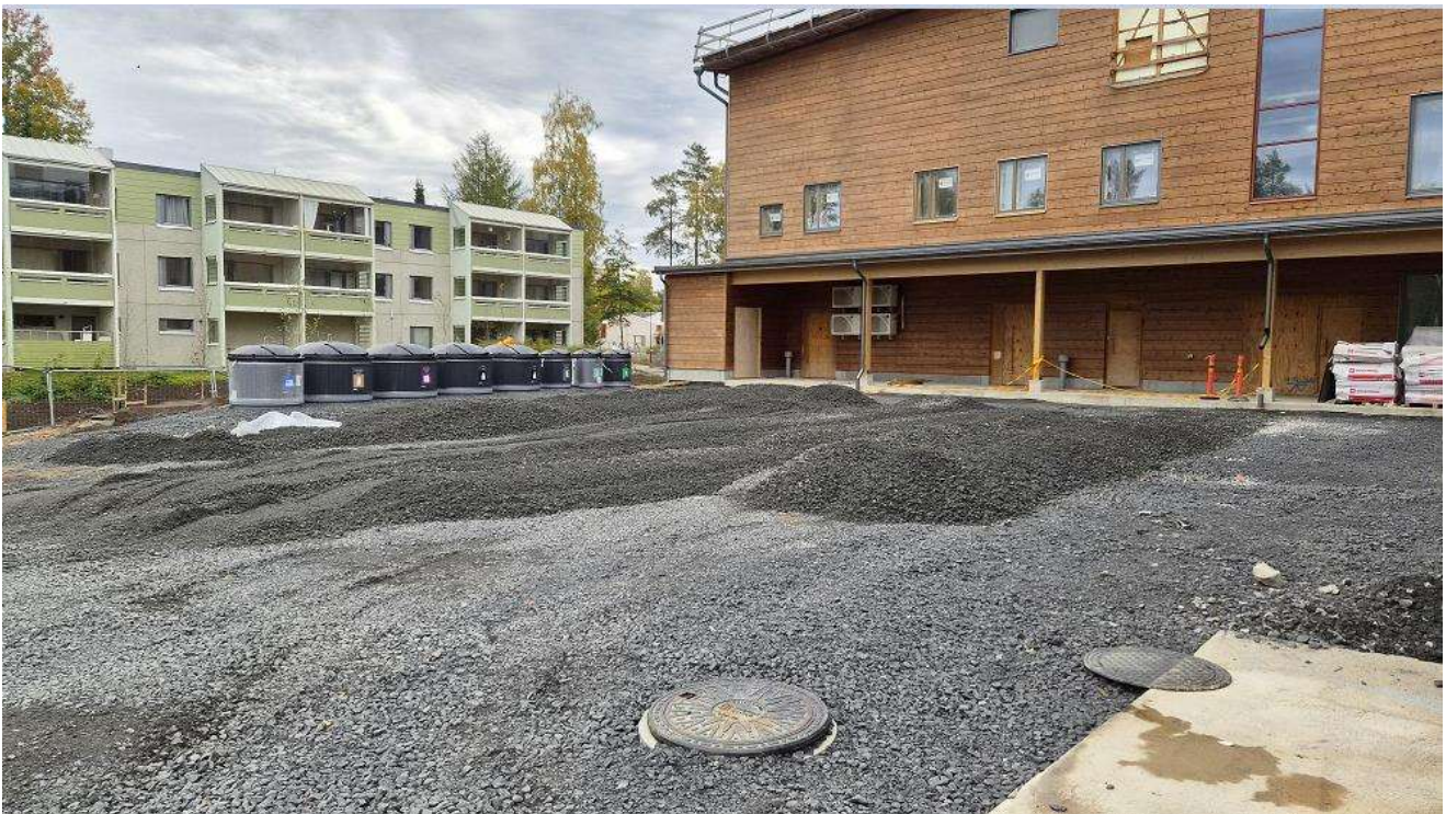
Lastauslaiturin edustalta alkaa asfaltin pohjatyöt. Kuva 23.9.2026
