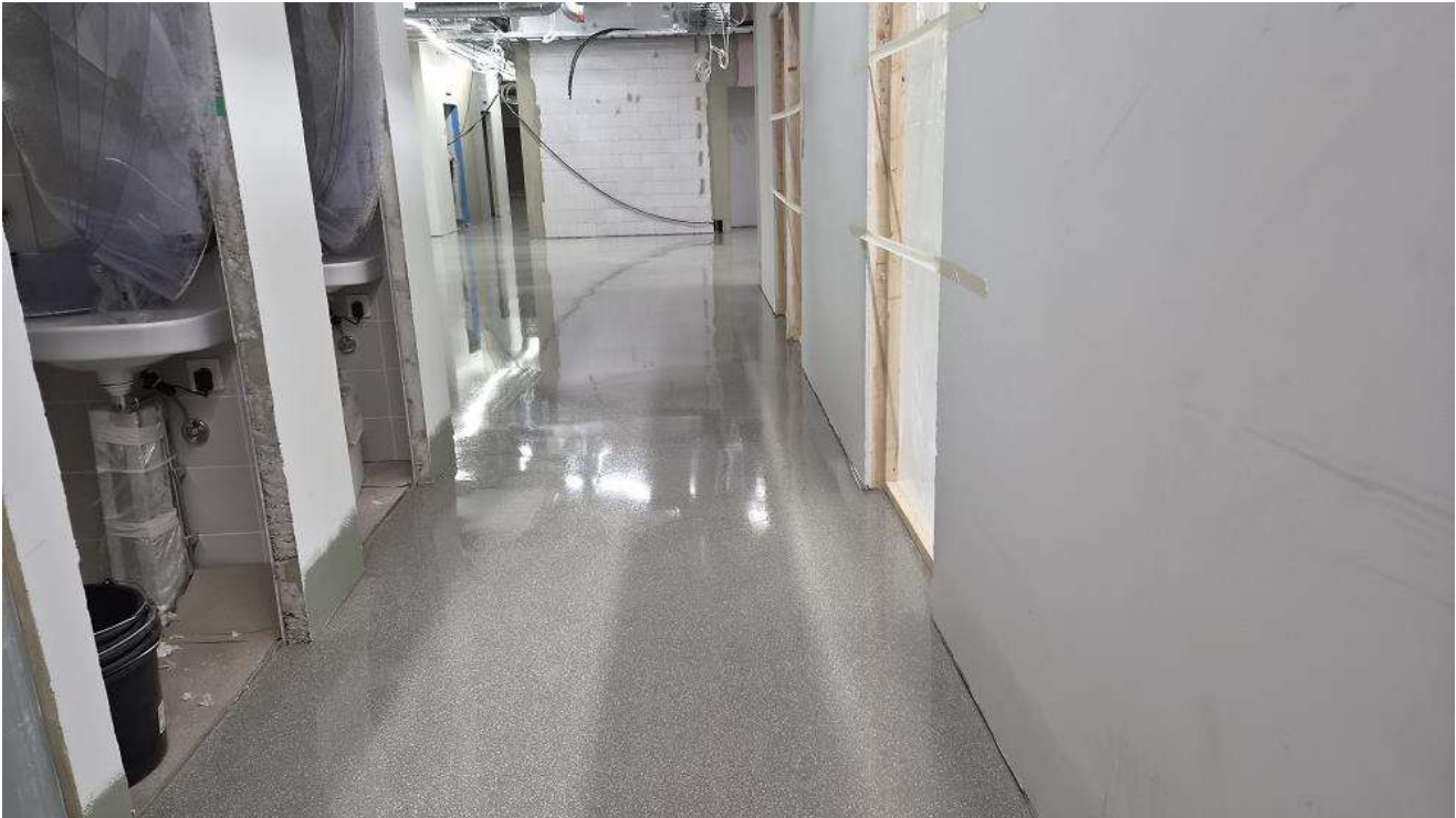
Koulun 2krs lattiapinnoitus käynnissä. Kuva 24.9.2026
