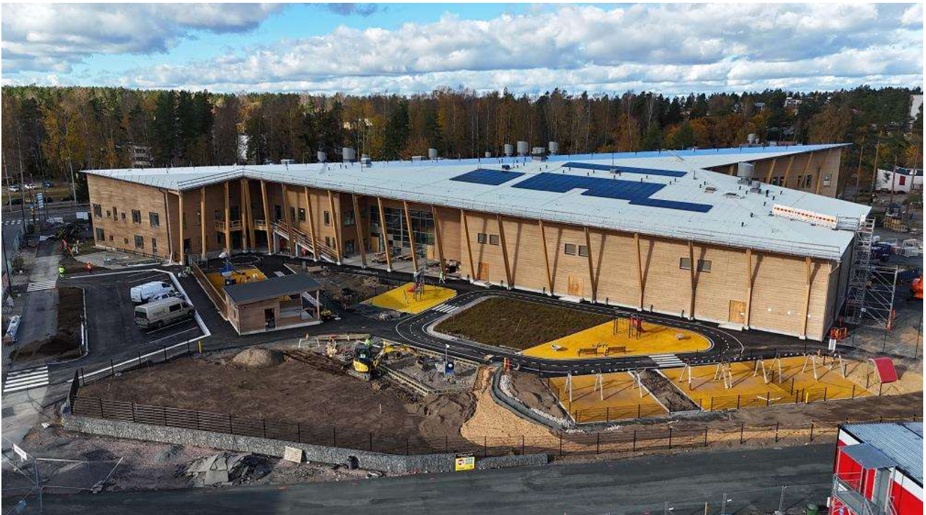
Yleisnäkymää työmaalle. Kuva 7.10.2026.
