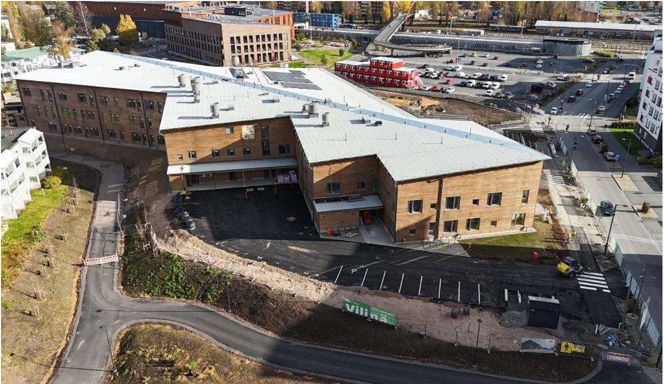
Yleisnäkymää työmaalle. Kuva 7.10.2026
