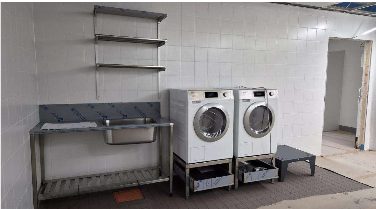
Siivouskeskuksen laiteasennukset käynnissä. Kuva 8.10.2026.
