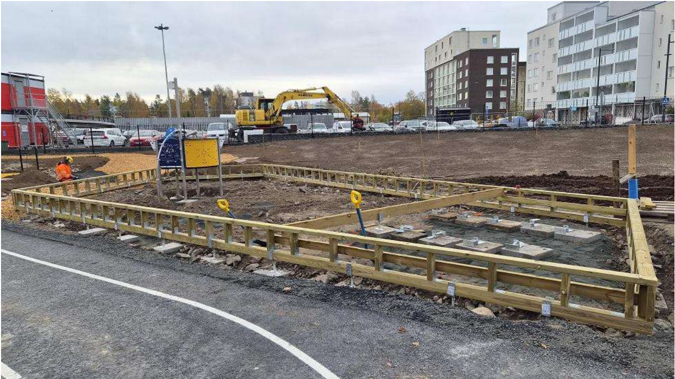
Hiekkalaatikon rakennustyöt käynnissä. Kuva 8.10.2026.
