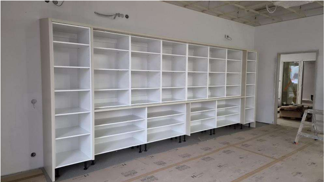
Kalusteasennuksia koulun alueella 1krs. Kuva 15.10.2026.
