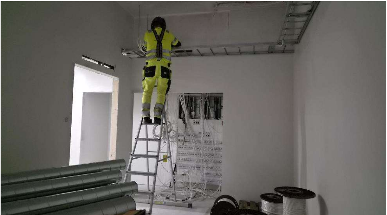
Sähkötöitä koulun puolella. Kuva 15.10.2026.
